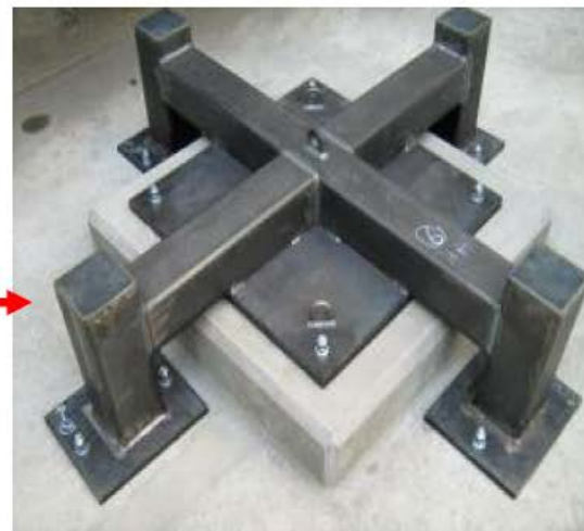
現在 (閉止板取り付け)
