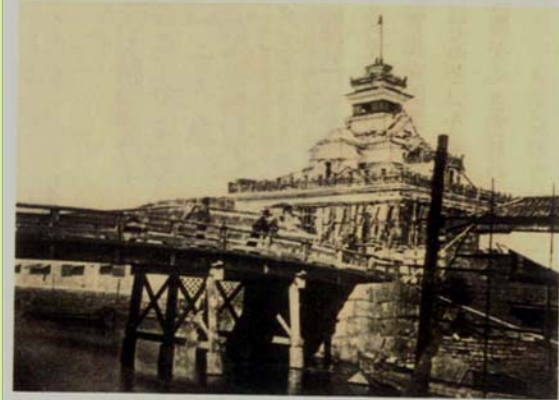
三井組ハウス(のちの第一国立銀行) 三野村利左衛門が1872(明治5)年に東京・兜町(海運橋)に和洋折衷5階建ての三井組ハウスを設立した。建物の設計施工は築地ホテル館を手がけた清水喜助。高さ36メートル、間口27メートル、奥行51メートルの周囲を圧する建造物だった。73年、第一国立銀行が誕生すると建物をそれへ譲り、三井は駿河町三井組ハウスに移転した。(上・三井文庫蔵、下・渋沢史料館蔵)
