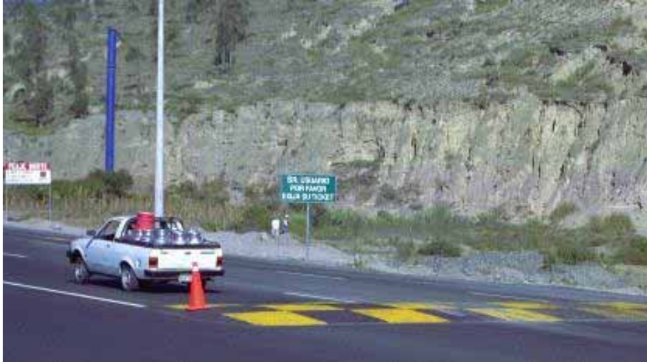
【写真3】道路の帯状突起
