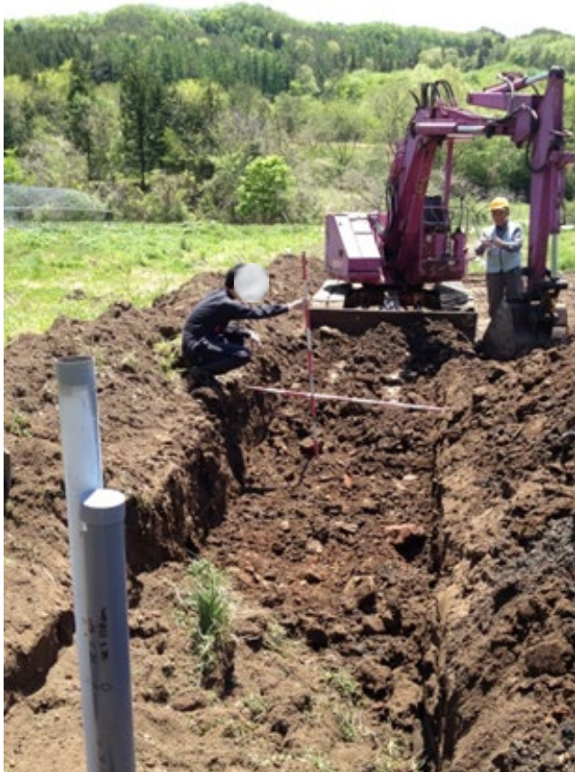
汚染土の埋設(2014.5.18)
